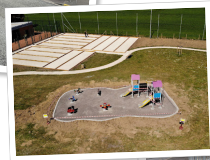
Le parc en travaux
